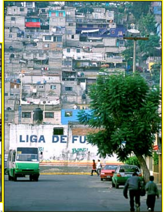
Asentamiento irregular en el Distrito Federal. Fuente: Mark Eduards Still Pictures y el Centrot de Transporte Sustentable de la Ciudad de México.
