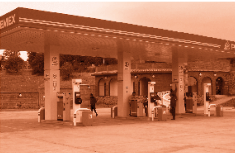
Construcción de una gasolinera en la Carretera Federal México-Cuernavaca
