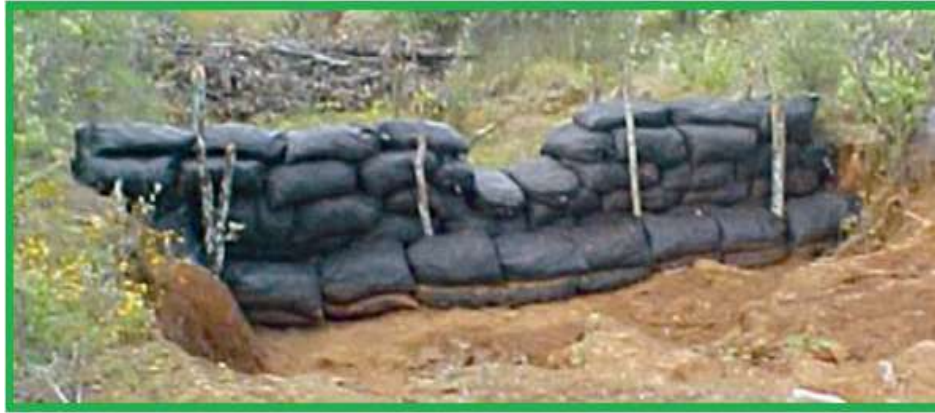
Fig. 25. Imagen de una presa de geocostal.
