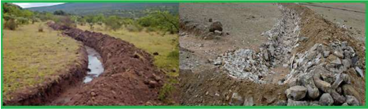
Fig. 9 Se ilustra una zanja de derivación recién excavada a la izquierda y una vez cabeceada para evitar arrastre de sedimentos a la derecha.
