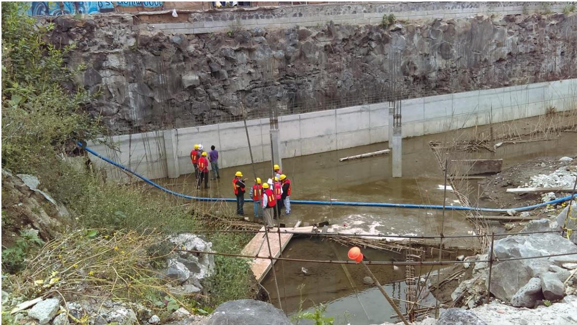
**Figura 28. Nivel del agua en la excavación, posterior al bombeo, con respecto al nivel de la calle.**
