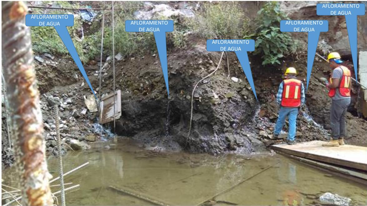
**Figura 27. Nivel de afloramiento de agua con respecto al nivel del agua en la excavación, posterior al bombeo.**
