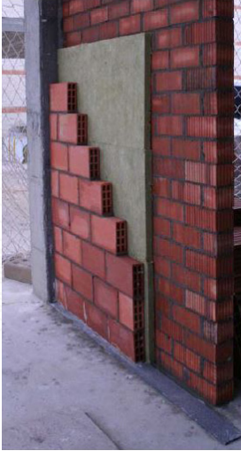
Mejora de aislamiento en paredes colindantes y fachada.
