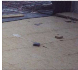
Mejora de aislamiento a ruidos de impacto mediante un piso flotante.
