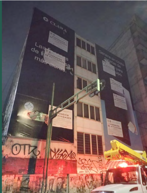
Viaducto Miguel Alemán 558, Del Valle Norte, Benito Juárez
