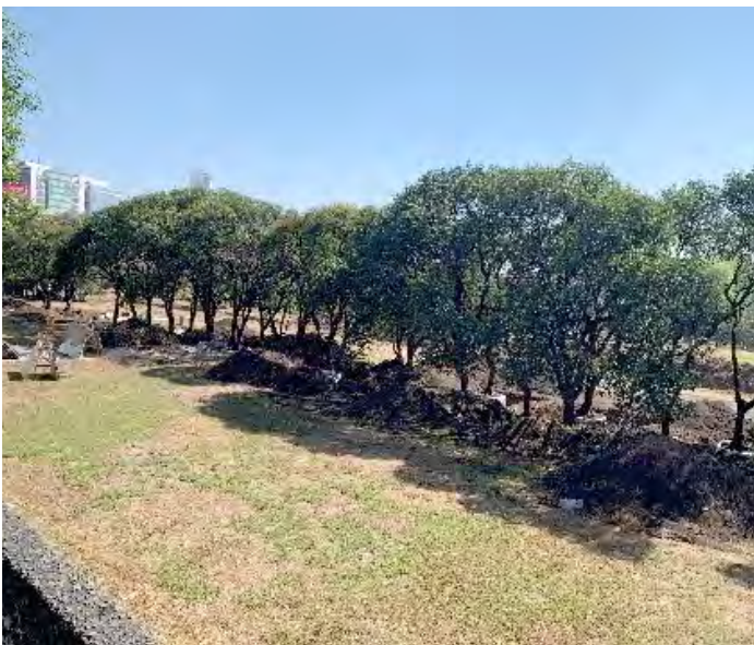
Estado actual de la construcción irregular
