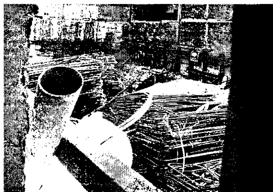
Imagen 2. Al interior del predio se están realizando actividades de obra nueva, en etapa de cimentación.
