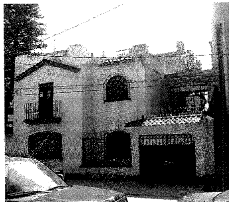
Imagen 2. Se observa inmueble de 3 niveles Reconocimiento de hechos por personal adscrito a PAOT Marzo 2017
