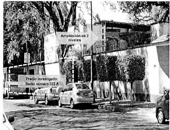
Imagen 2. Ampliación de dos niveles con estructura metálica en Berlín 303 A
