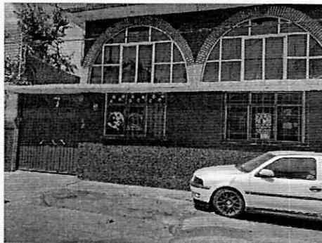
Figuras 1-3. Vista de las fachadas de los inmuebles en la calle Cadmio.
