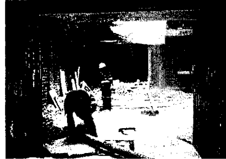
Foto 2. Se observa modificación de elementos estructurales al inmueble. Fecha: 23 de marzo de 2015, PAOT.
