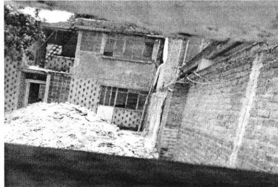
Imagen 2. Al interior del predio se ha demolido una sección del inmueble preexistente.
