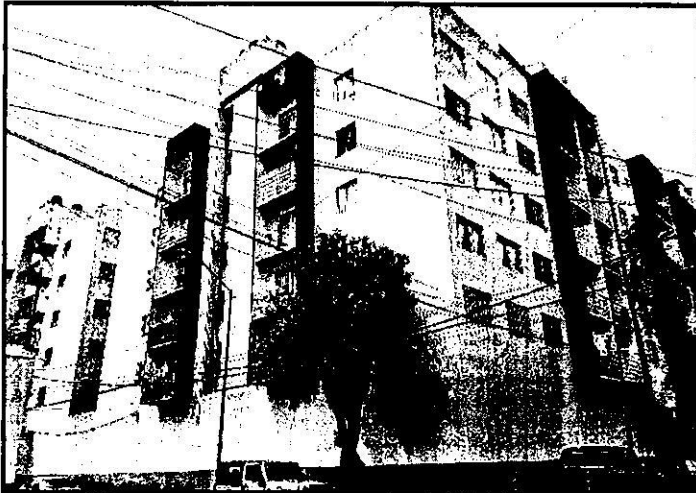
Imagen: construcción edificada en varias torres con semisótano y 6 niveles de altura, completamente concluida y habitada, en algunas de ellas se observaron estructuras a base materiales como durack y lamina.
