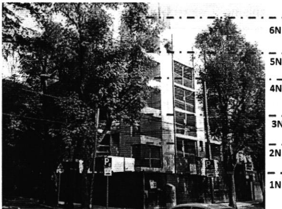
Imagen 1. Vista de los 2 frentes de la obra (Avenida Horacio y Goldsmith)
