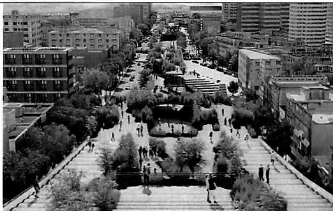
LA CALLE COMPLETA
