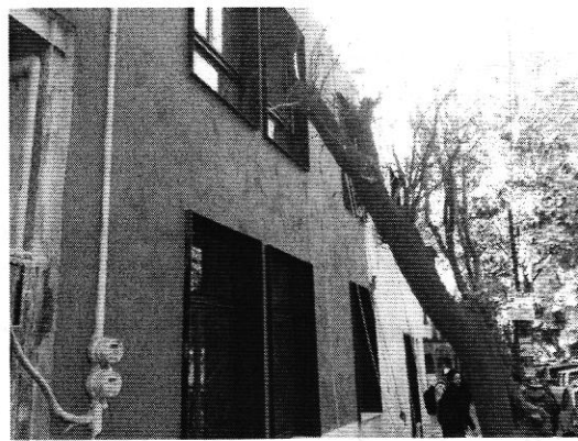
Imagen 1 y 2. Vista de la fachada del inmueble. (Fuente PAOT marzo de 2017).
