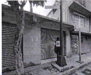
Figura 3. Vista del inmueble denunciado.
