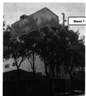
En las imágenes se observa el inmueble de reciente construcción constatado por esta Entidad en el sitio investigado, consistente en 7 niveles de altura, en la totalidad del predio.
