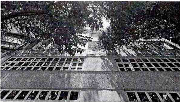
Imagen 3. Se observa que los dos niveles superiores fueron intervenidos en su fachada.
