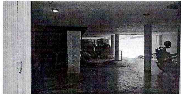
Imagen 4. Se observa el interior del inmueble, en donde se instaló un elevador, adicionalmente se observan materiales de construcción distribuidos en planta baja.
