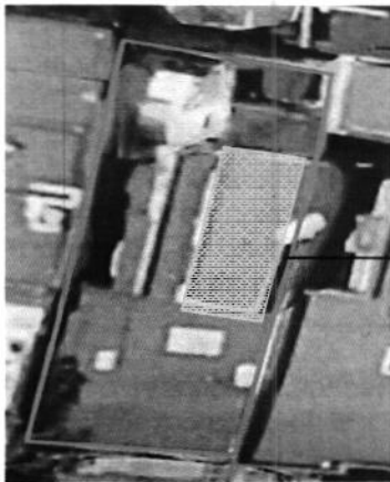
Cuerpo constructivo en la azotea
