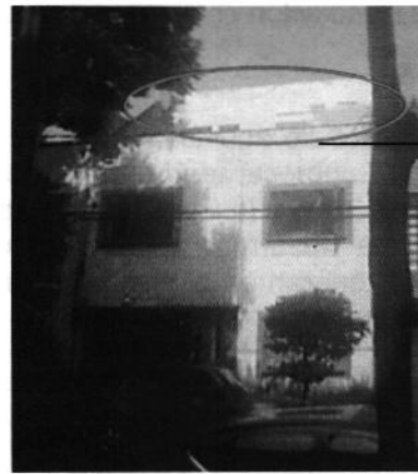
Ampliación de la edificación del tercer nivel.
