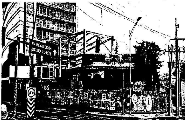
Imagen 1. Vista del predio objeto de investigación, en el que se advierte el desplante de un cuerpo constructivo a base de estructuras metálicas de 3 niveles y un inmueble preexistente de 2 niveles con demolición parcial.
