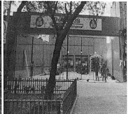
Reconocimientos de hechos de fecha 01 de noviembre de 2021, se constata la demolición del muro perimetral y la construcción de un mini súper al fondo del predio.
