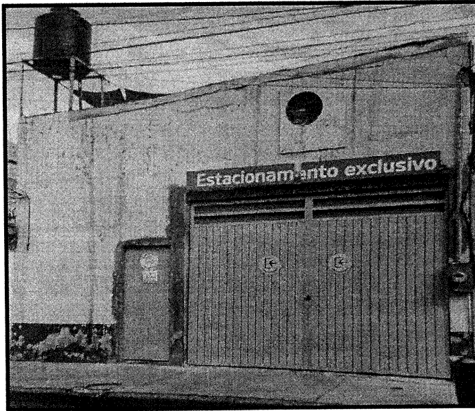
Fuente PAOT: inmueble objeto de diligencia, conformado por un nivel de altura.
