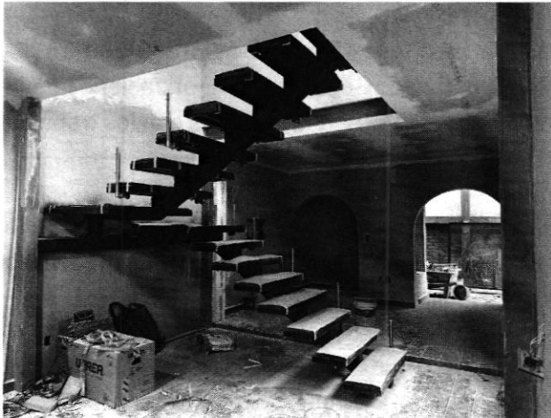
Habilitación de estructura de apoyo para desplante de escalera nueva. Fuente: PAOT, reconocimiento de hechos de fecha 22 de abril.
