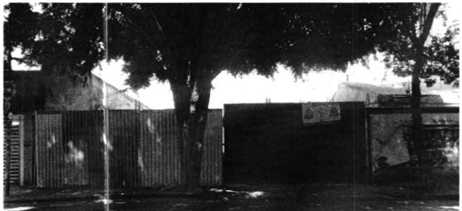
Sitio de obra en el domicilio investigado. Fuente: PAOT, Reconocimiento de Hechos de fecha 24 de marzo de 2026.
