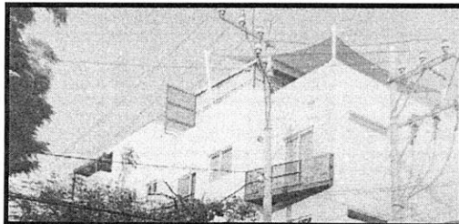
Nivel cuarto: dos elementos constructivos independientes, con techumbre en cada uno de los casos
