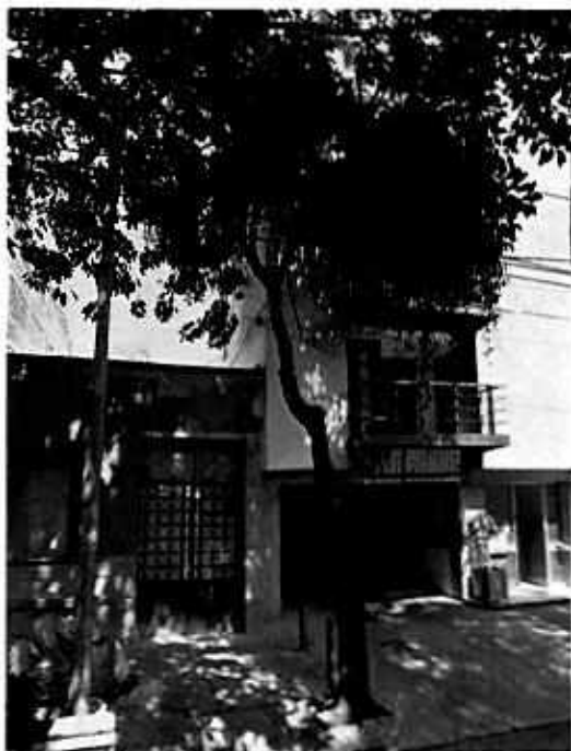
Fotografía 1. Se observa al árbol 1 inclinado hacia el predio.
