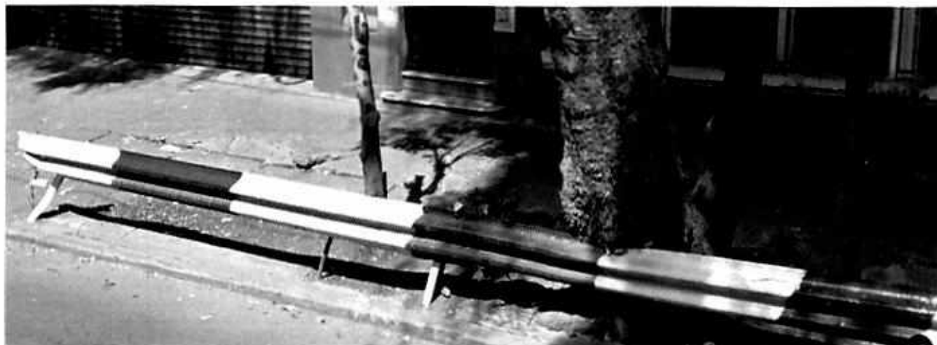
Fotografía 7. Se aprecia la inclusión en el tronco del árbol 3, así como el daño a la banquetta.
