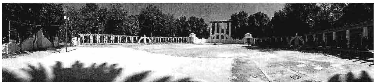
Fotografía 3.- Se muestra los trabajos que se realizaron en el Foro Lindbergh después de la intervención realizada en él.
