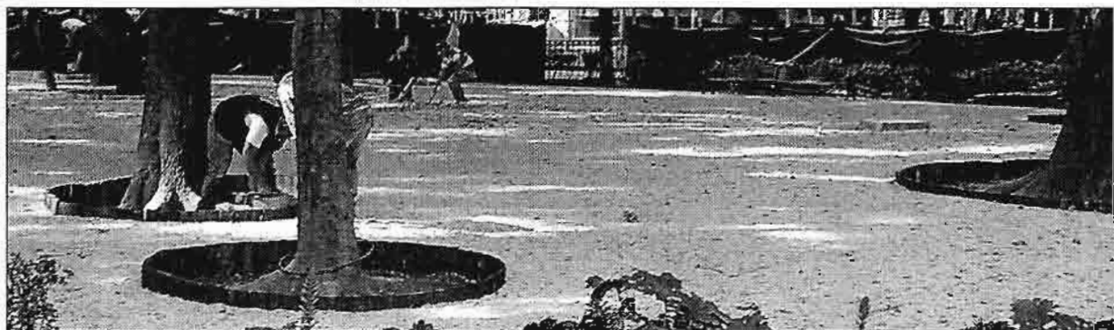
Fotografía 5.- Se observa a la constructora adecuando los cajetes de los árboles para respetar el crecimiento de los mismos.
