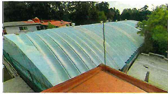
Fuente: Imágenes de diciembre de 2020, observando la colocación de cubierta de arco techo en la nave industrial terminada
