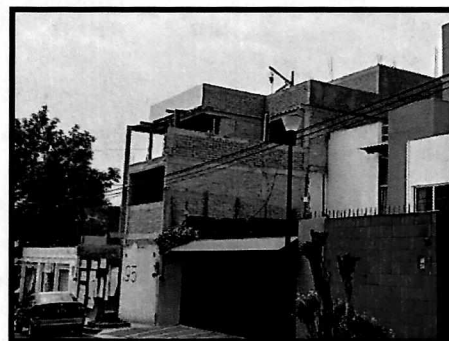
Imagen 3: En enero de 2018, se constató la ampliación en 2 niveles, por lo que el inmueble actualmente se conforma por 4 niveles de altura.
