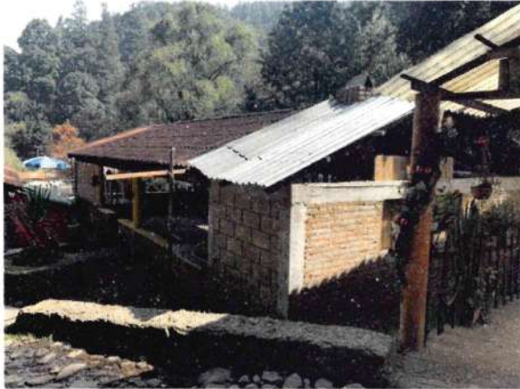
Ampliación horizontal consistente en el levantamiento de muro de mampostería, castillos y cadenas de cerramiento de concreto, así como una cubierta a base de lámina acanalada.
