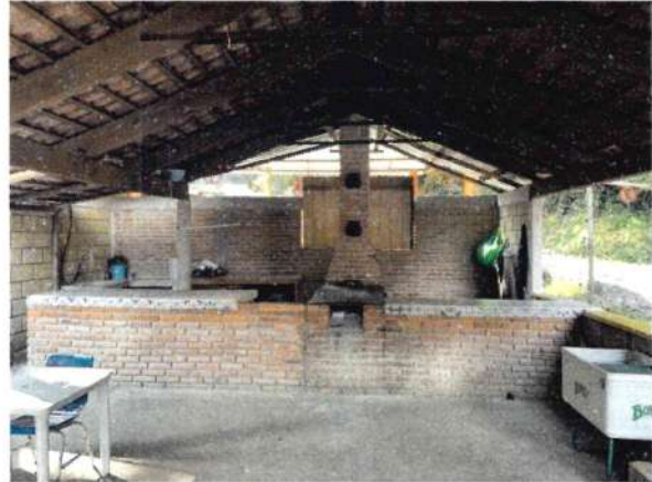
Ampliación horizontal consistente en el levantamiento de muro de mampostería, castillos y cadenas de cerramiento de concreto, así como una cubierta a base de lámina acanalada.
