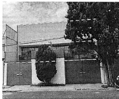
Fuente: Reconocimiento de hechos realizado por PAOT
