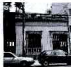
Imagen obtenida de reconocimiento de hechos de fecha 14 de julio de 2016; en el comparativo se identifica que en el inmueble no se ejecutaron trabajos constructivos.
