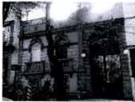
Imagen obtenida del Reconocimiento de hechos de fecha 13 de julio de 2016; en el comparativo se observa que a fachada de sitio no fue objeto de modificación.
