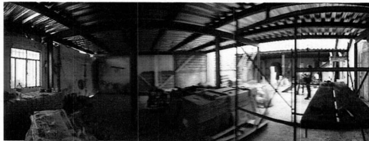
Imagen 3: se observa el interior del inmueble edificado a base de estructuras metálicas y entrepiso de losa cero se observan trabajadores y materiales de construcción.
