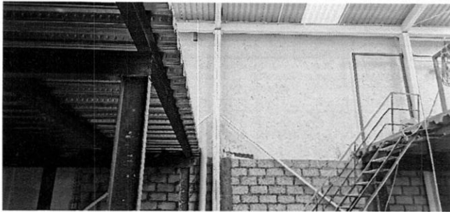
Imagen 1: se observa una estructura metálica con entrepiso de losa cero y levantamiento de barda
