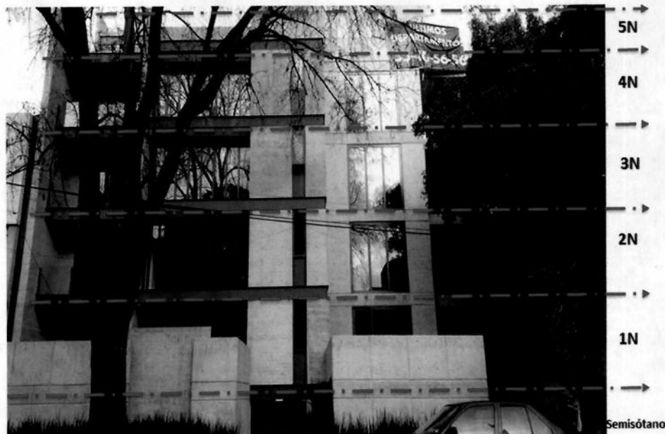
Imagen 1: Se observa un inmueble de 5 niveles, en etapa de acabados.
