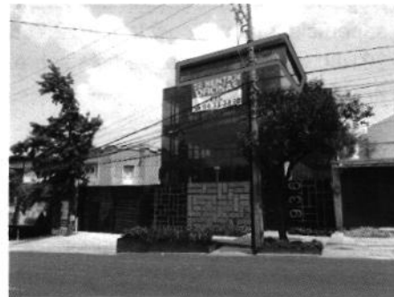
Imagen 3: se observa el 4 nivel desplantado en casi la totalidad de la losa del tercer nivel.
