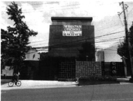
Imagen 2: se observa el inmueble con características físicas distintas al uso habitacional.
