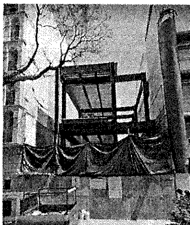
Imagen 3: Fuente Street view de google maps de octubre 2014. Se observa la estructura metálica a base de vigas de acero desplantada en dos niveles, con entrepiso de losacero.
