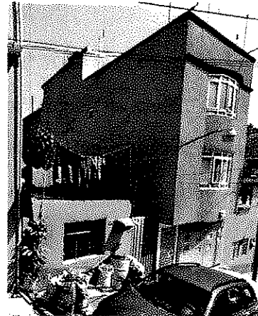
Street View Google Maps Noviembre 2022
