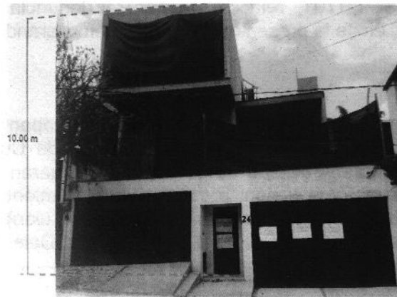
Imagen 1: se observa la construcción con 10 metros de altura
