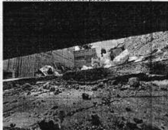
Vista hacia el interior del predio
