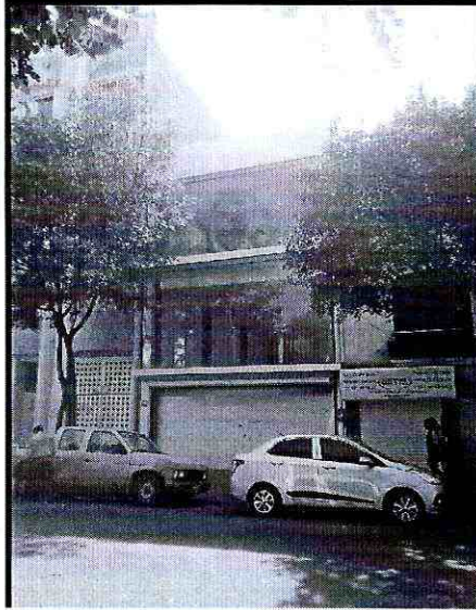
En las imágenes se muestra que en el sitio existe algún cuerpo constructivo de 3 niveles en el predio objeto de denuncia
