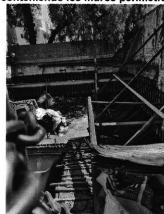
Imagen No. 2 - Se observan perfiles metálicos conteniendo los muros perimetrales.
