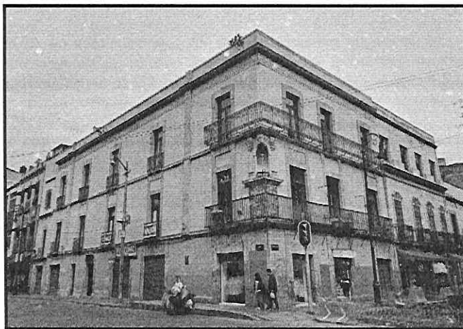
Fuente PAOT-Reconocimiento de hechos de fecha 25 de octubre de 2021: inmueble objeto de diligencia, conformado por un tres niveles de altura sin instalación de la estructura metálica en su azotea de altura.
