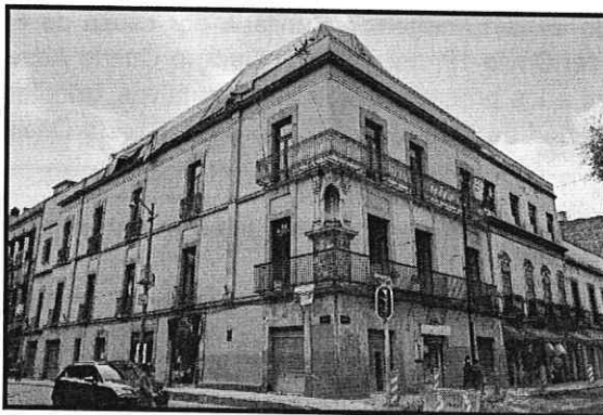
Fuente PAOT-Reconocimiento de hechos de fecha 12 de agosto de 2021: inmueble conformado por un tres niveles de altura y la instalación de una estructura metálica semipermanente en su azotea de altura.
