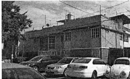
Fuente: Reconocimiento de Hechos realizado por PAOT. 16 de febrero 2022
