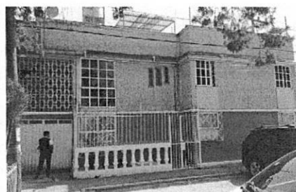
Fuente: Reconocimiento de Hechos realizado por PAOT. 16 de febrero 2022
