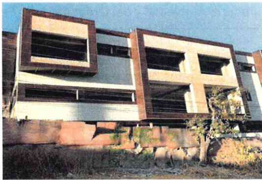
Fotografía proporcionado por el denunciante de fecha 18 de febrero de 2021 Edificación de un cuerpo constructivo de 2 niveles en etapa de obra gris desplantado en la mayor parte del terreno
