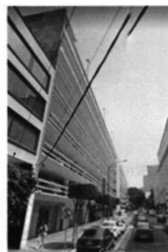
Vista: Calle Oso
