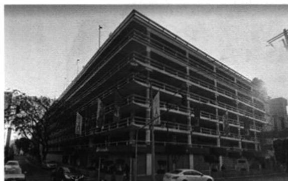
Vista: Esquina Calle Oso y Calle Parroquia
