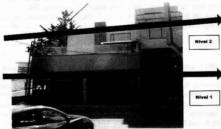
En la imagen se observa el inmueble en construcción constatado por esta Entidad de 2 niveles de altura
