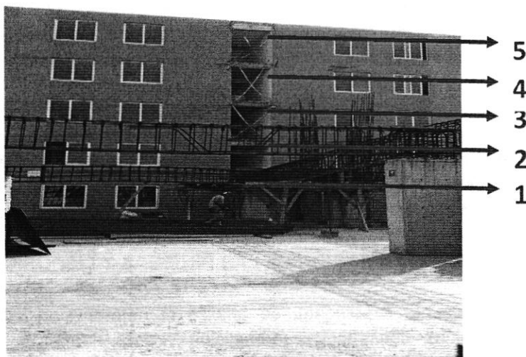
Imagen del interior del predio, se observan actividades de construcción de un nuevo cuerpo constructivo.
