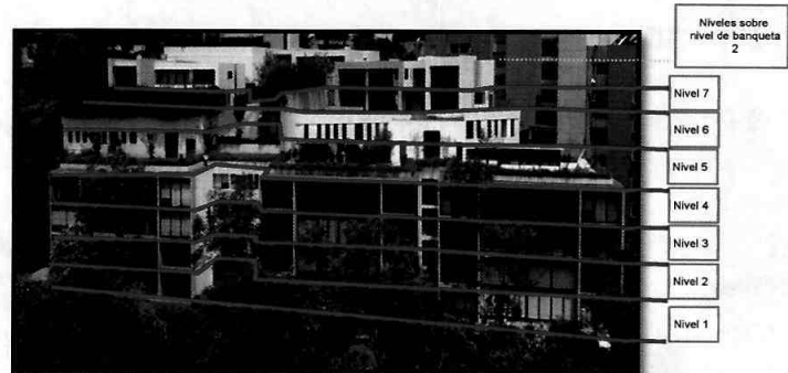
Imagen; inmueble de 7 niveles de altura bajo el nivel de la banqueteta Fuente: Reconocimiento de hechos (05 de septiembre de 2018)
