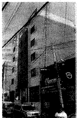
Imagen No. 4.- Inmueble de 5 niveles preexistentes, se observa la ampliación del sexto nivel.
