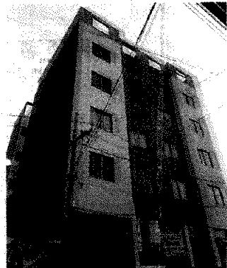
Imagen No. 5.- Inmueble de 5 niveles preexistentes, se observa que la ampliación del sexto nivel no contaba con losa.
